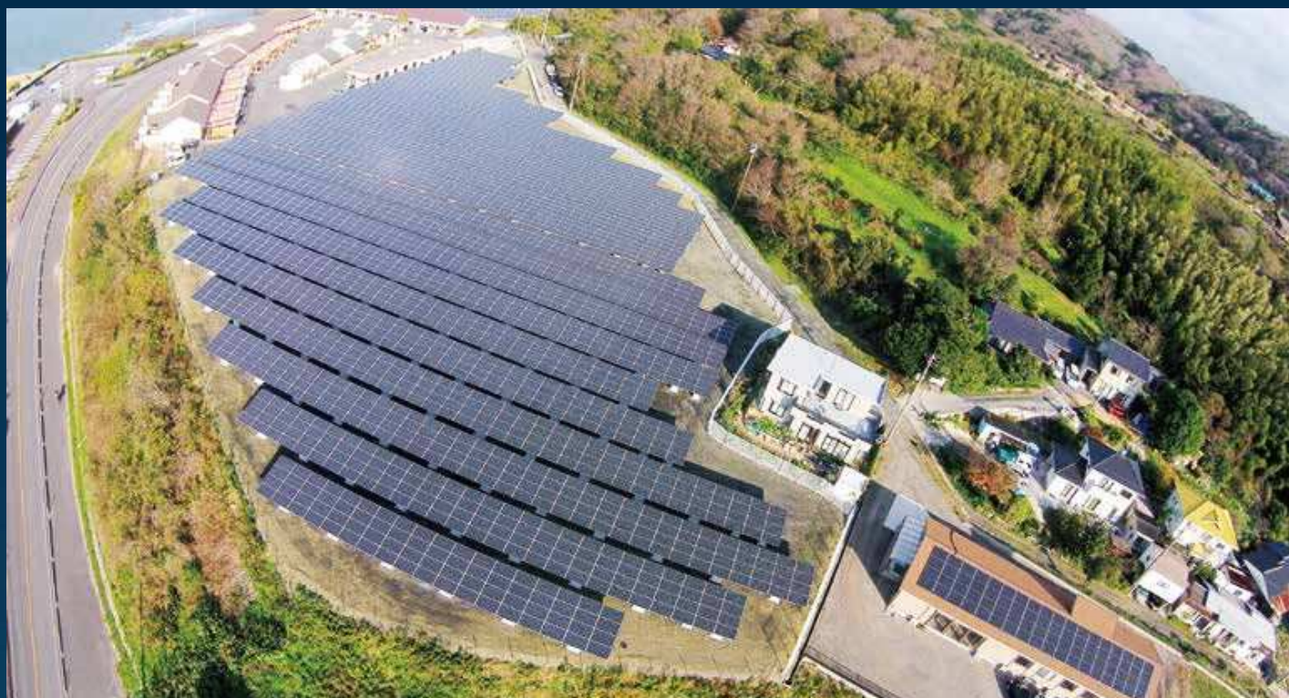
32 小野田太陽光発電所
